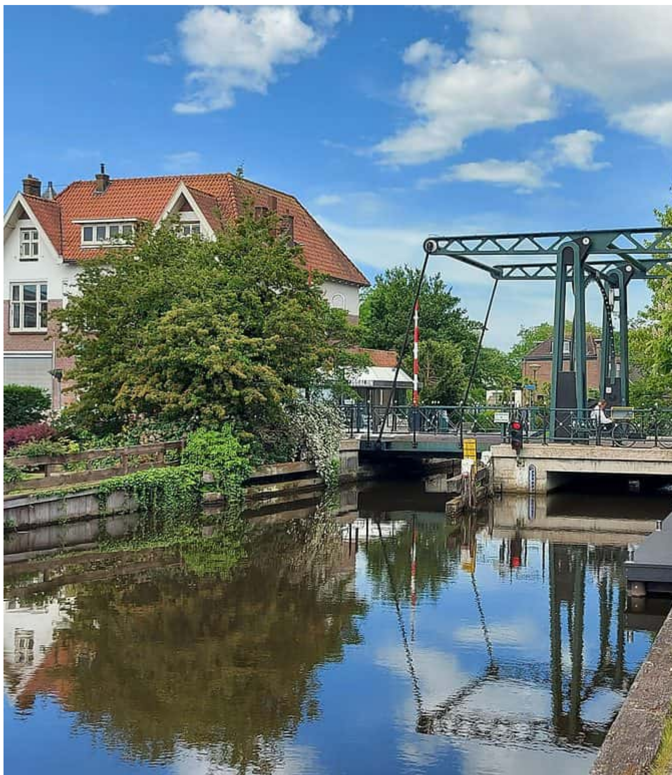
Hefbrug over de Angstel
